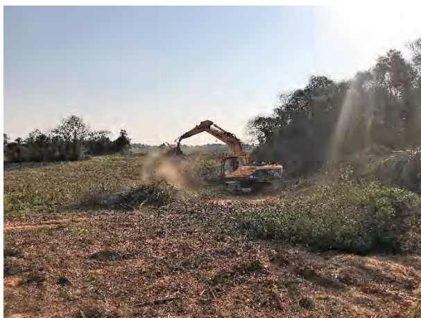
Foto 23 – Escavadeira Pinça realizando a atividade de triagem do material florestal (Registro Fotográfico 10/09/2020).
