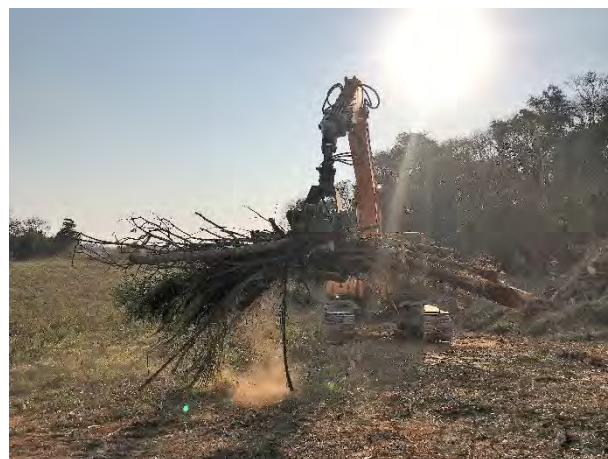
Foto 24 – Escavadeira Pinça na atividade de separação dos produtos florestais (Registro Fotográfico 10/09/2020).
