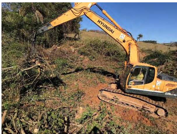
Foto 11 – Escavadeira Pinça realizando a atividade de triagem do material florestal (Registro Fotográfico 26/08/2020).
