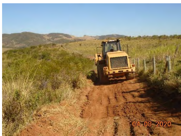
Foto 17 – Manutenção de aceiro efetuado de forma mecanizada.
