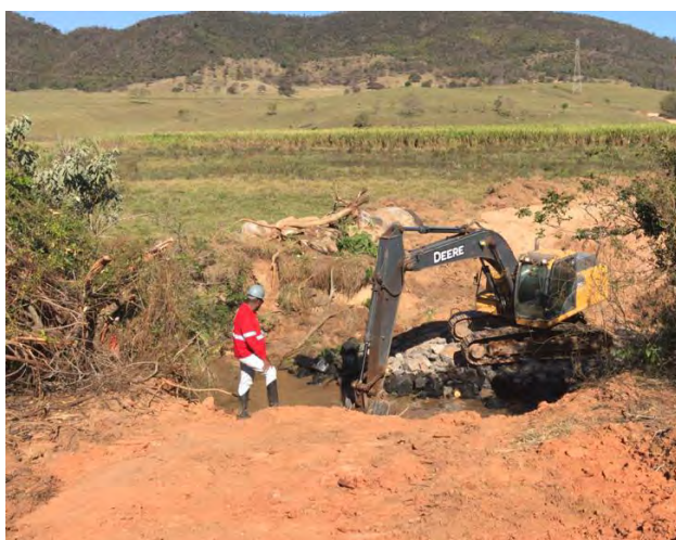
Foto 1 – Execução da Passagem Molhada no córrego Pantaleão. (Data: 26/08/2020)
