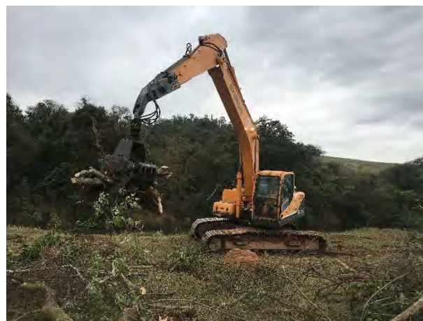
Foto 12 – Escavadeira Pinça na atividade de separação dos produtos florestais (Registro Fotográfico 26/08/2020).
