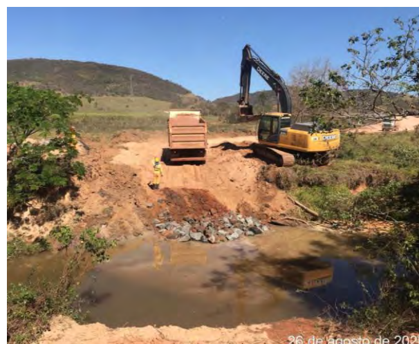
Foto 2 – Execução da Passagem Molhada no córrego Pantaleão. (Data: 26/08/2020)
