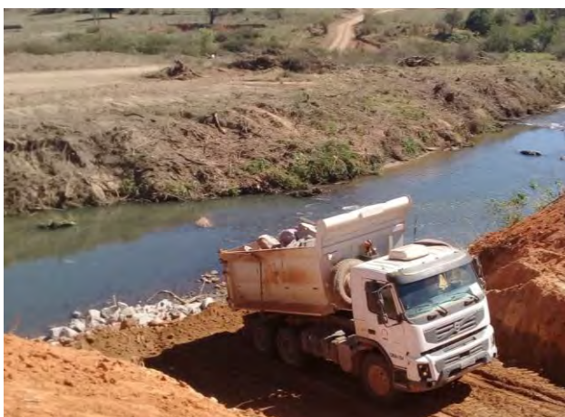
Foto 3 – Execução da Passagem Molhada no rio Camanducaia. (Data: 30/08/2020)
