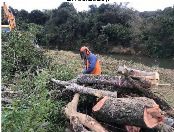
Foto 9 – Atividade de traçamento (Registro Fotográfico 25/08/2020).
